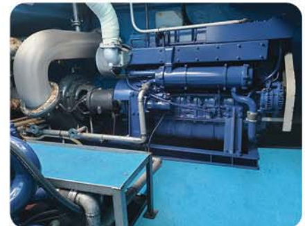
[ 펌프 설치 현장 ]
